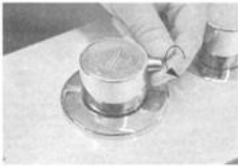
2. odšroubujte vystávající element kohoutku
