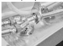
6. odkręcenie przyłącza wody
